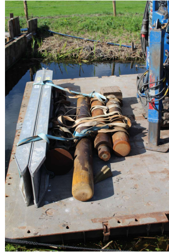
Ponton met heistelling, holle buispalen En verschillende maten heiblok
