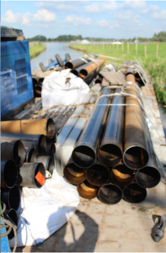
Ponton met heistelling, holle buispalen En verschillende maten heiblok
