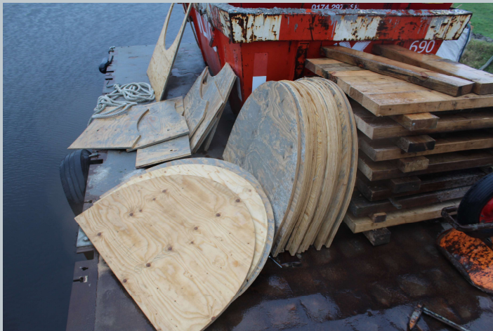
En Thomas rookt een sjekkie... O nee, hij zaagt de mal voor bekisting van de vijzelkom.
