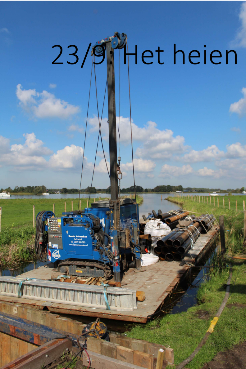
Ponton met heistelling, holle buispalen En verschillende maten heiblok
