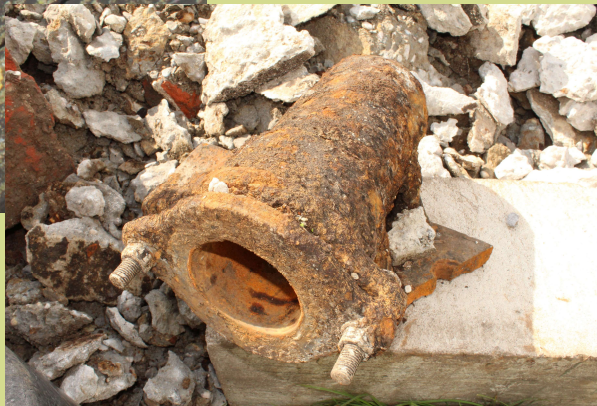
Het gebroken onderlager van de vijzel
